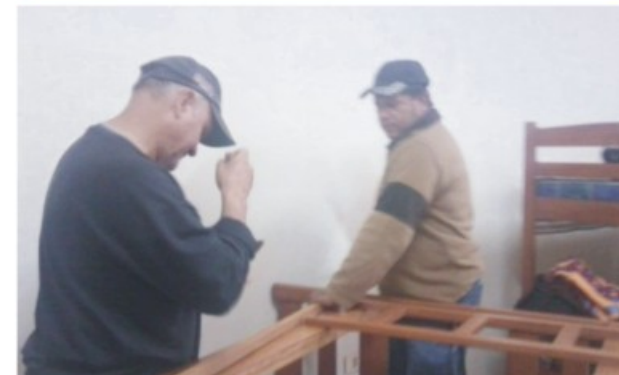
Don Peti y Don Cesar realizando tareas de mantenimiento.
